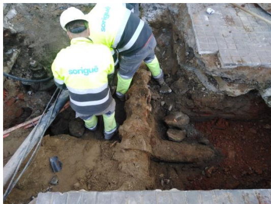
5. Detall de la canalització existent.
