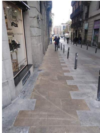
10. Vista general de finalització dels treballs al carrer dels Tallers
