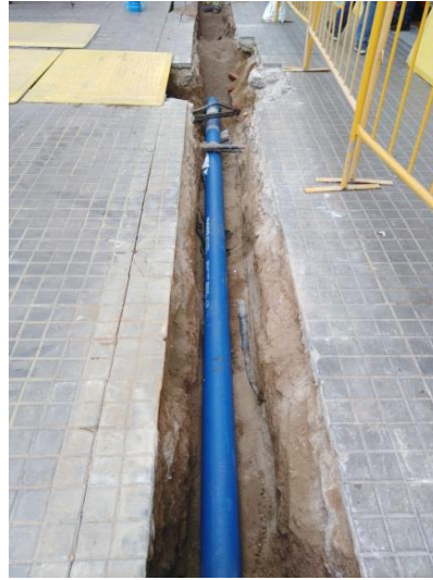
8. Instal·lació de la canalització a la Plaça de la Universitat .
