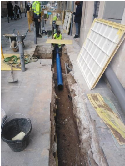
3. Instal·lació de la canalització al carrer dels Tallers
