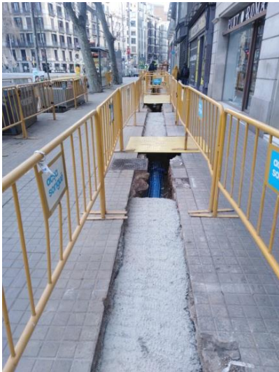
9. Vista general de finalització dels treballs a la Plaça de la Universitat
