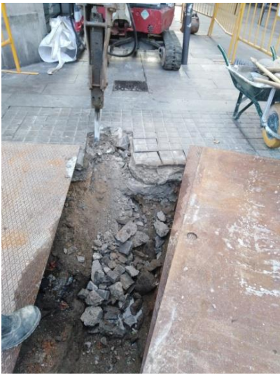
1. Vista inici del rebaix a llevant del carrer dels Tallers.
